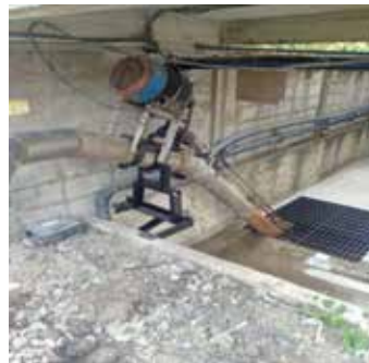
▲ 1) ดำเนินการติดตั้งเครื่องสูบน้ำที่รางน้ำฝนเพื่อป้องกันน้ำฝนเข้าสู่ระบบน้ำเสียเพื่อรักษาคุณภาพแวดล้อมทางน้ำรอบชุมชน
