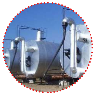
โครงการพลังงานหมุนเวียน ที่ไม่เชื่อมโยงกับระบบสายส่งไฟฟ้า (Off-Grid)
